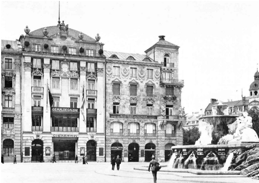
Blick auf das Gebäude der Galerie Heinemann, München, Lenbachplatz 5/6.
